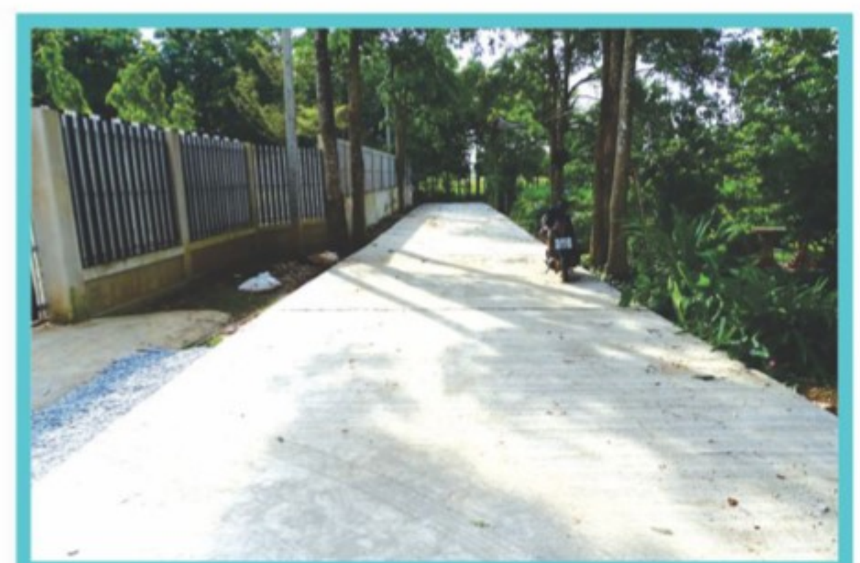
ก่อสร้างถนน คสล. หมู่ที่ ๑๑ ซอยพิรภัทร (ต่อ)
