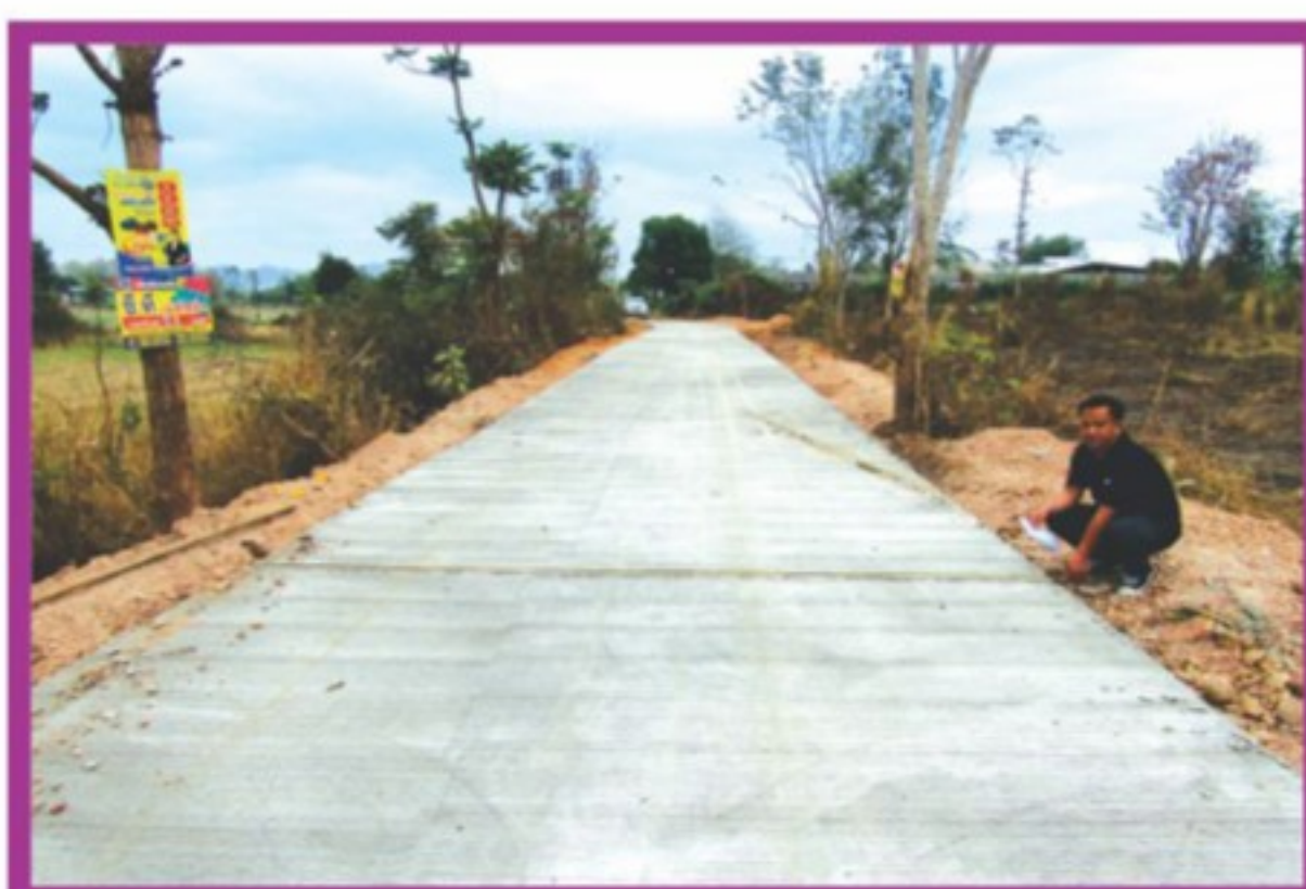
ก่อสร้างถนน คสล. สายข้างวัดห้องสูง หมู่ที่ ๓ ถึงหมู่ที่ ๑๐ บ้านป่าสัก
