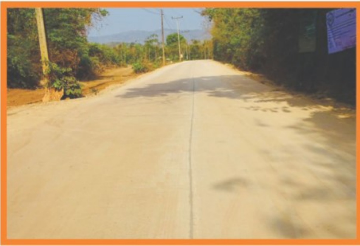
ก่อสร้างถนนคอนกรีตเสริมเหล็ก สาย อต.ถ.๒๘-๐๐๒ แยก ทล.๑๐๔๑-ในดงนาทะเล
