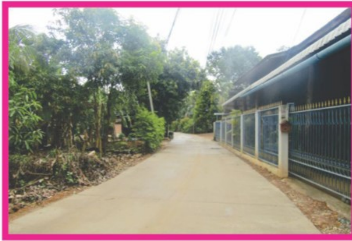
ก่อสร้างถนน คสล. หมู่ที่ ๔ ซอยคุ้ม ๒ ดาวลอย ตั้งแต่บ้าน นางผัน คชหาร ถึงบ้านนายแล แก้วสอน
