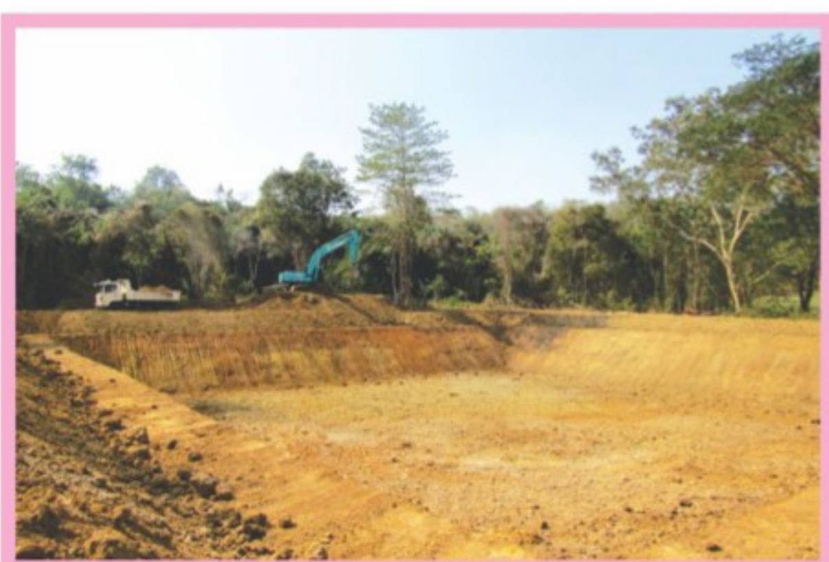
ขุดสระเก็บน้ำหมู่ที่ ๗ บ้านห้วยมุ่น
