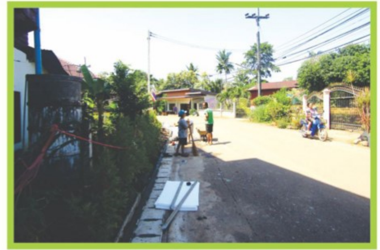
ก่อสร้างรางระบายน้ำ คสล. หมู่ที่ ๑๐ บ้านป่าสัก หน้าบ้านนางจันทร์ มาแก้ว
